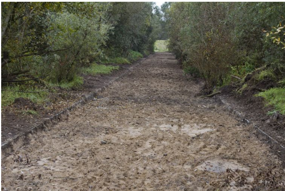
Abb. 8: NATO-Straße nach Entnahme und Abtransport des Bodenpflasters
